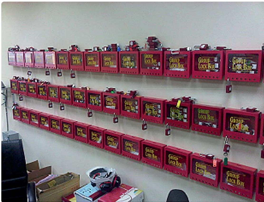
Групповые боксы и блокировочные центры хорошо использовать для индикации ремонта. Определите конкретное место для нахождения бокса при ремонте крупного оборудования и к какому производственному участку относится каждый центр.
